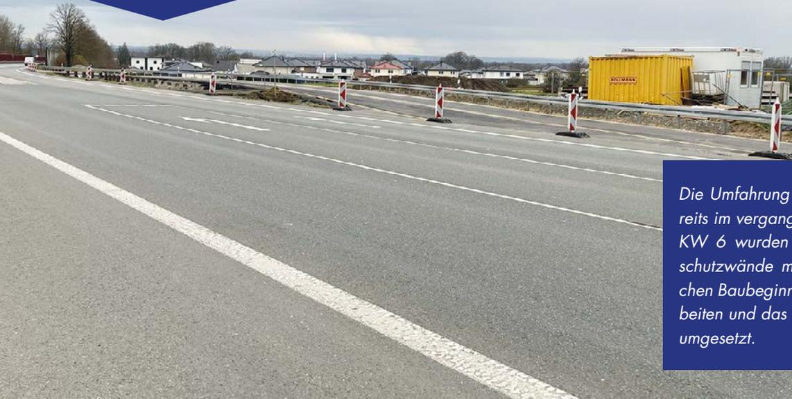
Die Umfahrung am Fahrbahnrand wurde bereits im vergangenen Jahr hergerichtet. In der KW 6 wurden am Fahrbahnrand die Gleitschutzwände montiert und vor dem eigentlichen Baubeginn die Fahrbahn-Markierungsarbeiten und das Aufstellen der Straßenschilder umgesetzt.
