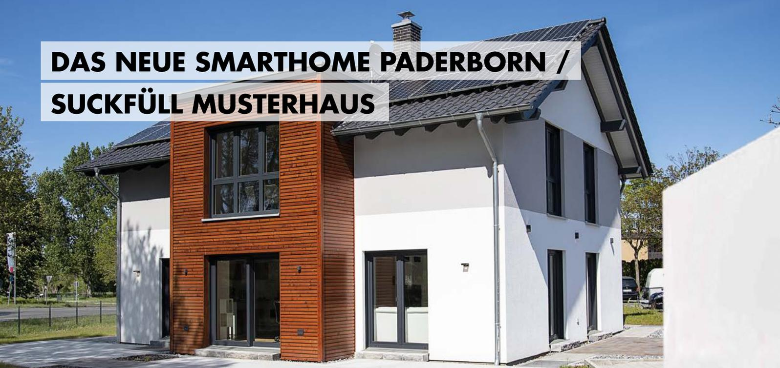
Das von der Firma Suckfüll gebaute Smarhome Paderborn ist ein großzügig gestaltetes, zweigeschossiges Einfamilienhaus mit 185 m<sup>2</sup> Wohnfläche. Es hat kaum Schrägen im Obergeschoss, da der Dremmel eine Höhe von 2,00 m hat und das Satteldach eine Neigung von 30°.
